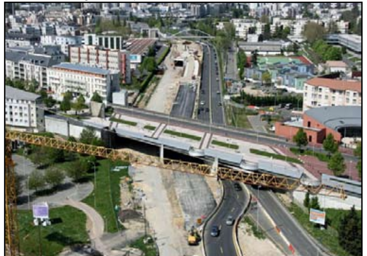
Vue aérienne du prolongement de la ligne 8
