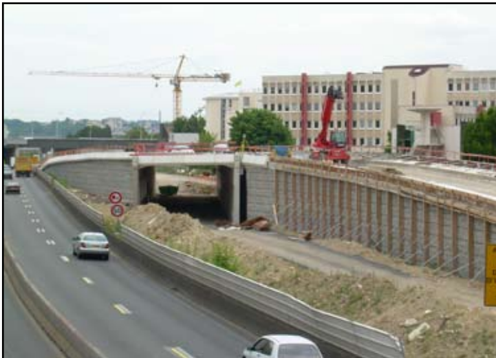
Vue du saut de mouton en construction
